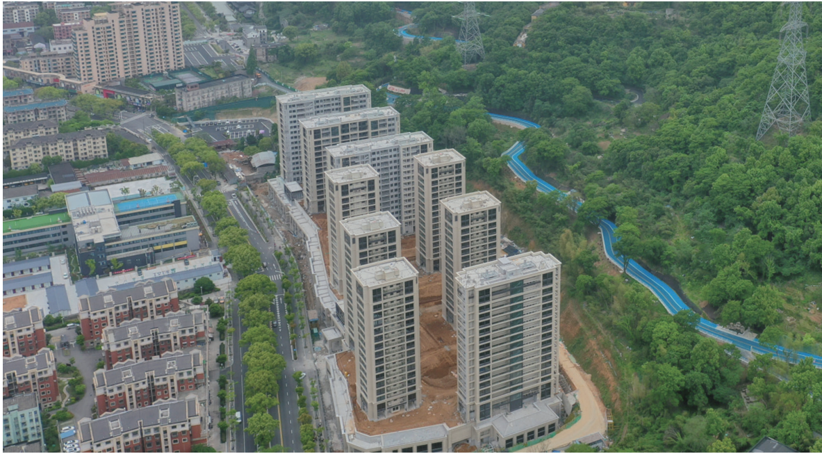
西山路西侧安置项目
