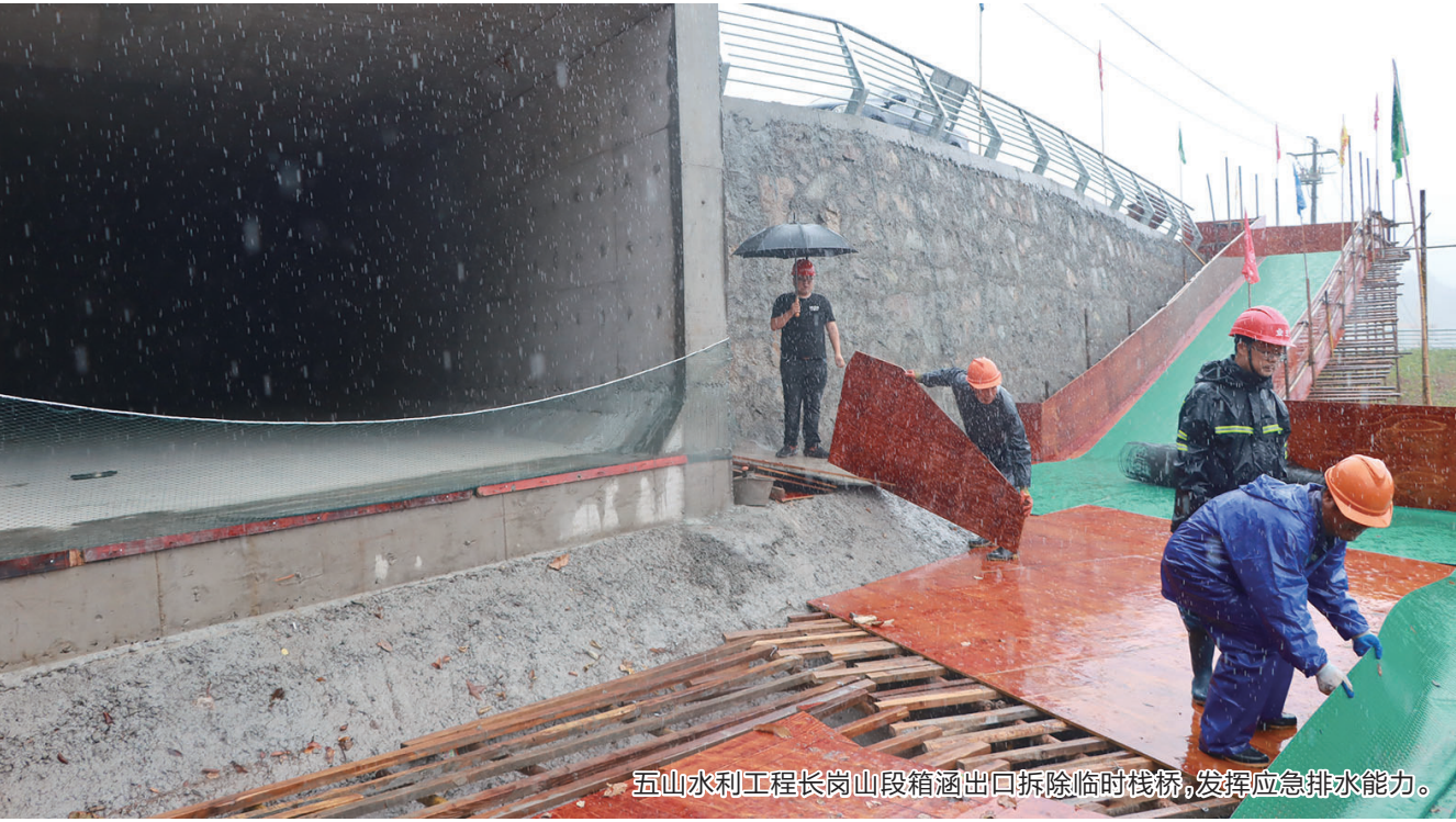
五山水利工程长岗山段箱涵出口拆除临时栈桥,选择应急排水能力。
