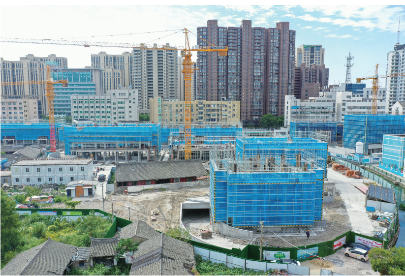
廷佐小学南侧安置项目完成基础结构施工
