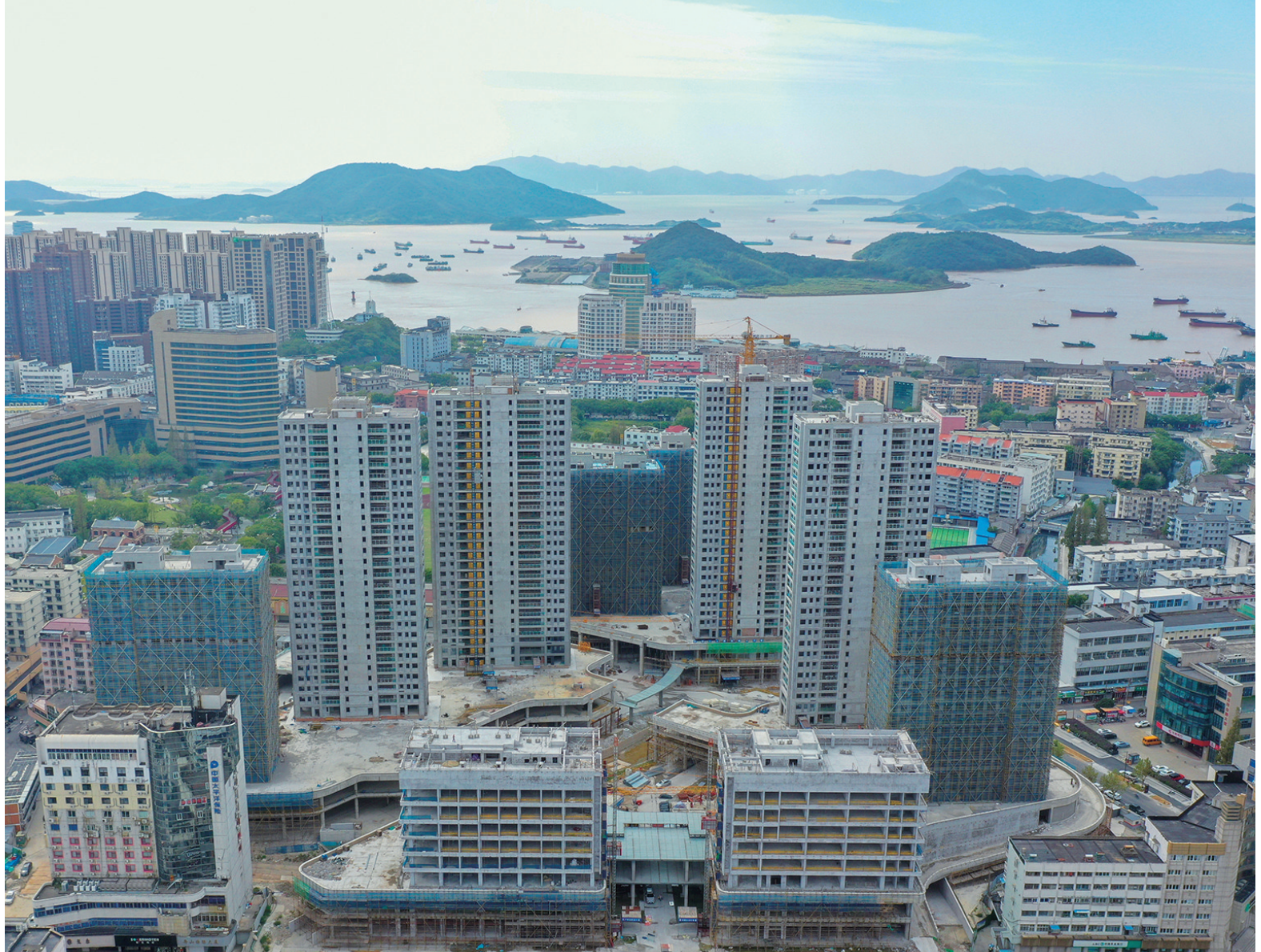
工农路安置项目完成主体结构施工
