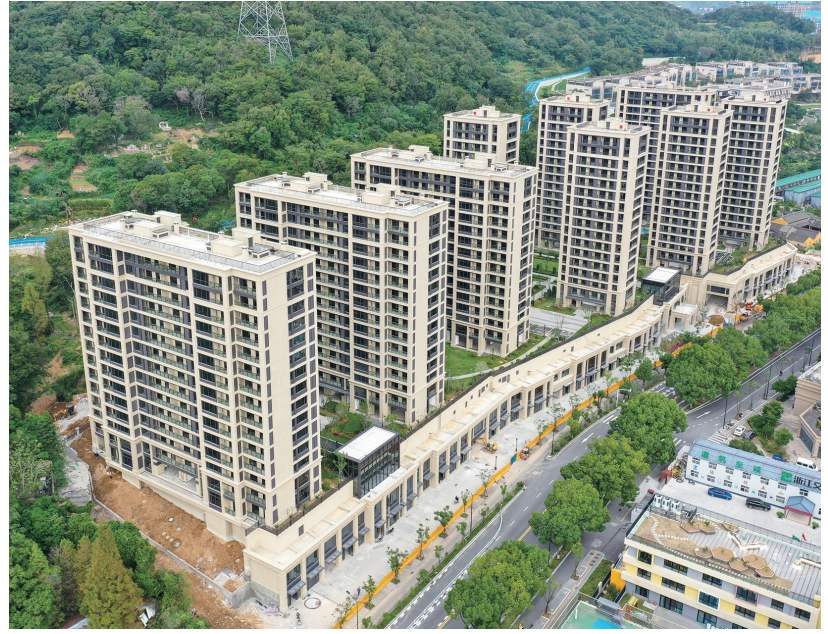
西山路西侧安置项目进入扫尾阶段
