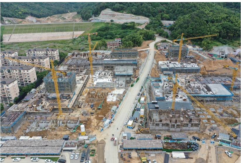
东湾安置项目进入主体施工阶段
