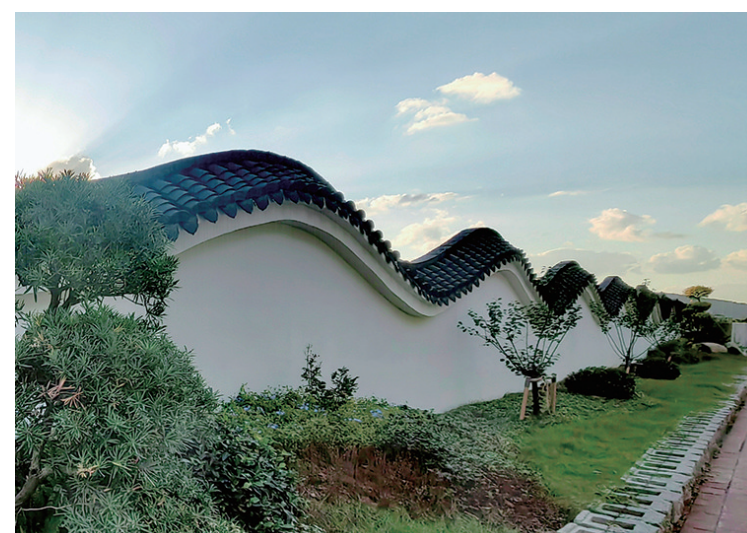
青垒头路沿线景观绿化提升工程
