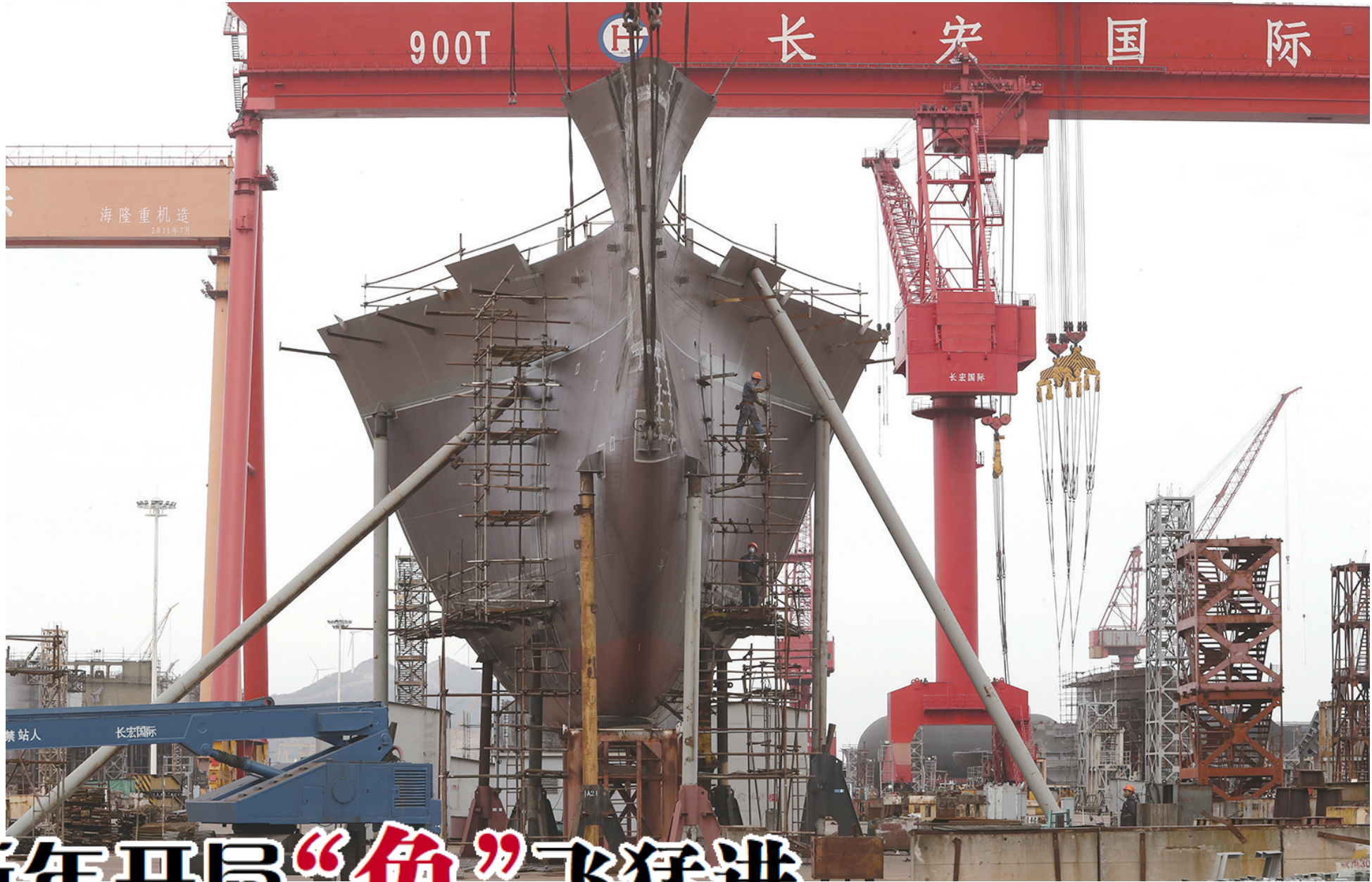
「长宏国际」施工场景一派繁忙
