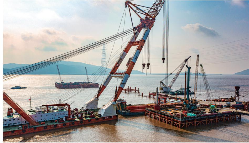
记者近日在西堠门公铁两用大桥建设现场看到，工人们正在焊接金属钢架，并进行5号主塔墩的搭建工作，同时大桥建设专用的起重机和钻孔机在现场进行打钻作业。据了解，西堠门公铁两用大桥是甬舟铁路及甬舟高速公路复线跨越西堠门水道的跨海桥梁，全长3118.226米，4号墩和5号墩为主塔墩，主跨采用1488米斜拉悬索协作体系，桥面宽68米，是目前世界上跨度最大的在建公铁两用大桥。大桥选取“公铁平层”布置，中间为铁路，两侧为公路；铁路为双线客运专线，公路为双向6车道高速公路。施工方计划在今年底完成主塔墩钻孔桩建设，在2024年至2025年的上半年进行塔柱施工，在2025年下半年到2026年开始进行钢梁架设，计划到2028年底完成全桥土建工程。
