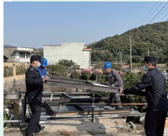
白泉镇鼓足干劲，拆除违建“顽疾”。
