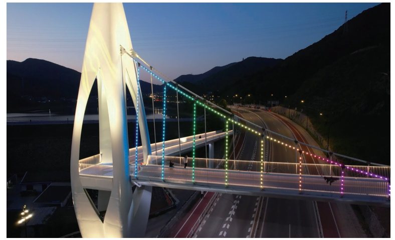
定马线飘带桥
