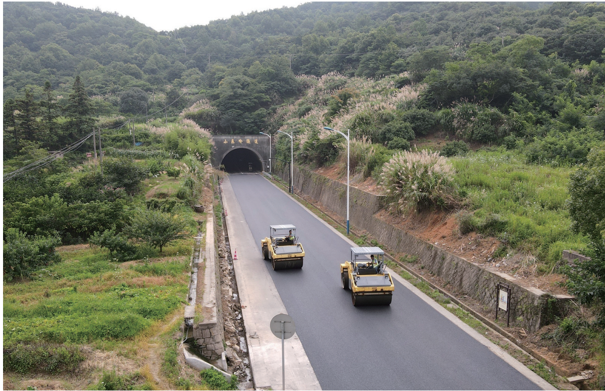
据介绍,2023年S308省道舟山环线定海段(原鸭东线)养护大中修工程起于白泉镇柯梅村,终止小展岭隧道出口100米左右处,路段长度约7.33公里,计划工期3个月。施工方将合理安排施工工期及流程,争取在7月底完成主体工程建设。
