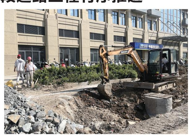
路,东北接未来社区现状道路,全 长近1.3千米,标准路段宽度23 米,将进行雨污水管铺设、桥梁新 建、路灯、消防水及弱电管线工程 等内容。
