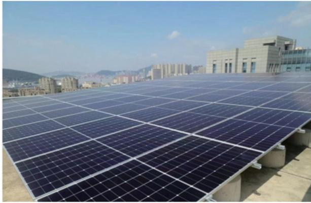
余电上网”原则，优先使用光伏发电模式，年均发电8万千瓦时。该项目运行周期20年，累计发电160万千瓦时，预计可节约标准煤196.64吨，减少二氧化碳排放840吨，有力推进该公共机构向绿色低
