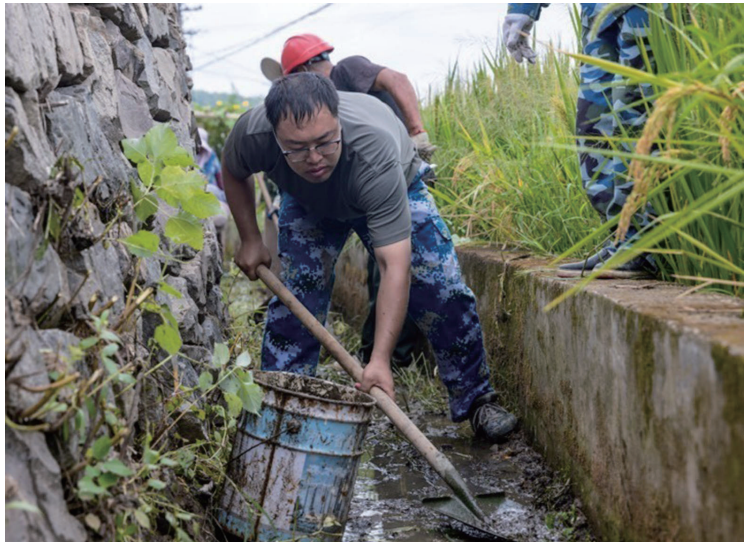
清理沟渠畅通排水
