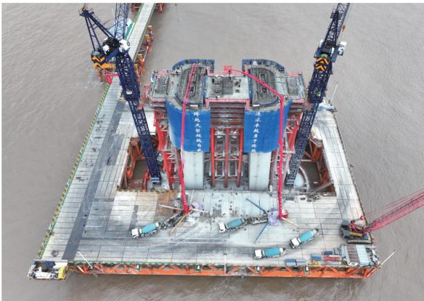
如此规模的大桥,下横梁更要结实,为保证主塔与下横梁结构的整体性,防止下横梁由于长度大、承载大而容易开裂的风险,在施工中,他们采用下横梁与塔柱同步施工,且一次性浇筑完成。
