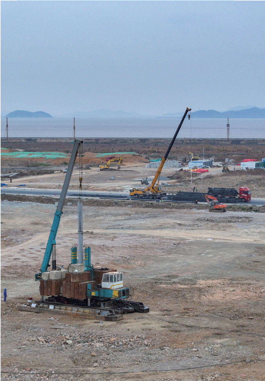
天賦宏云生物燃料油项目桩基施工现场
