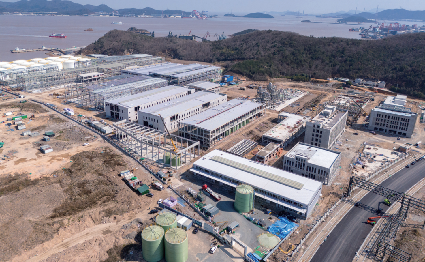
浙江聚泰新能源电池正极原材料项目厂房及附属设施施工现场
