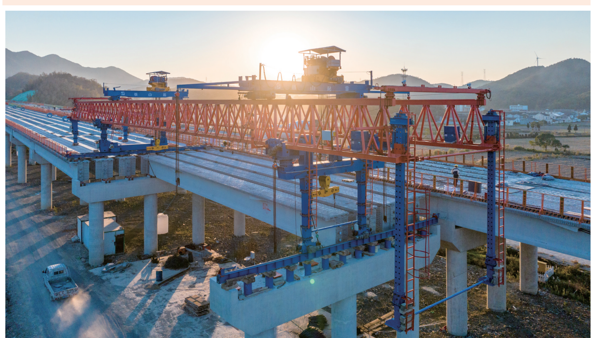
甬舟高速复线一期工程
