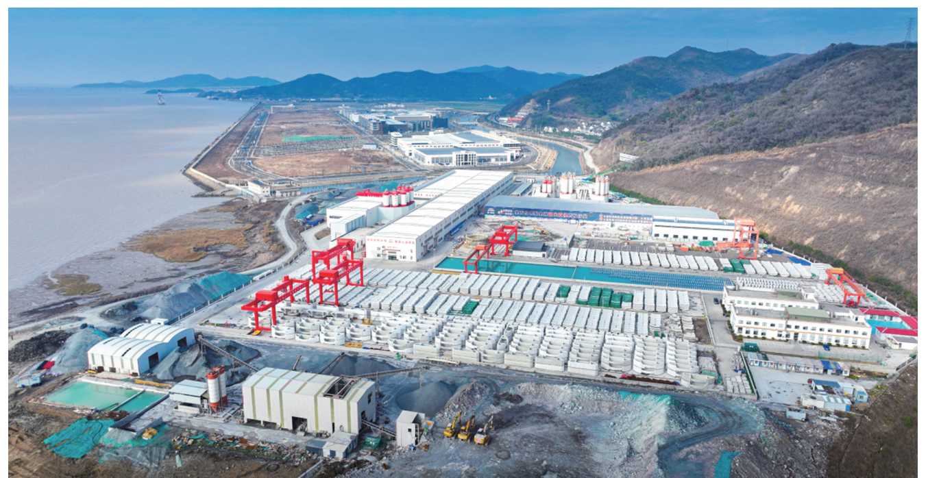
甬舟高速复线二期项目加紧建设
